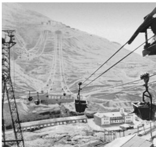
Рис.1. Грузовая подвесная канатная дорога для транспортировки руды.
