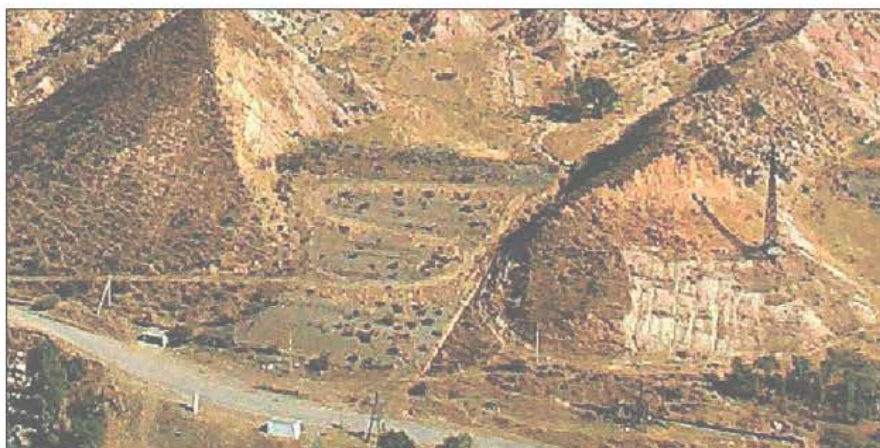
Рис.2. Общий вид хвостохранилища № 3 накануне его реабилитации
