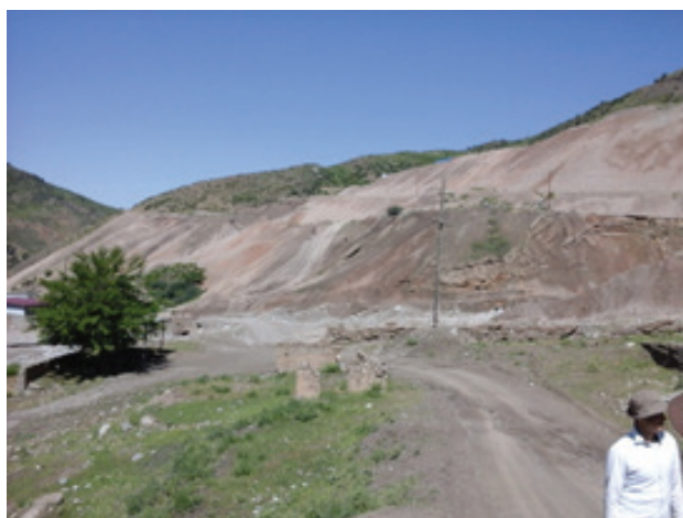
с) Вид отвала с востока
